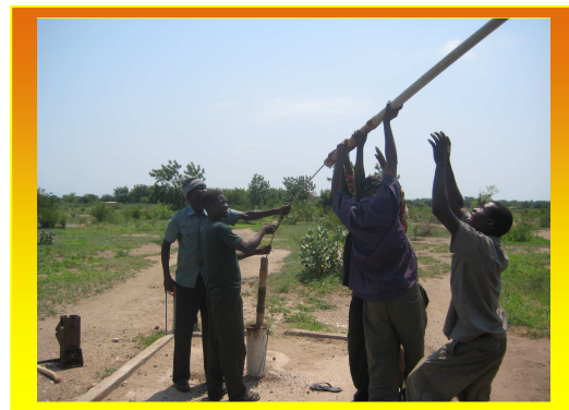
Arbeiten am Brunnen
