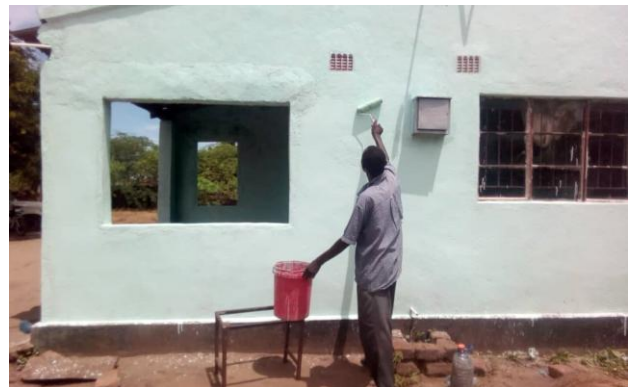
Renovierung des AAA-Hauses
