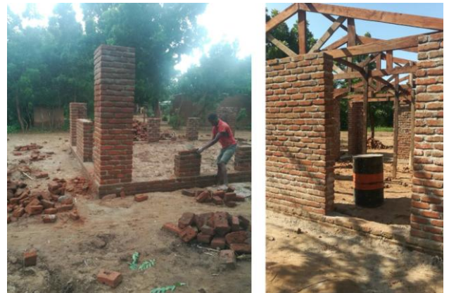
Aufbau einer Unterstell-Halle für den Betrieb einer Maismühle
