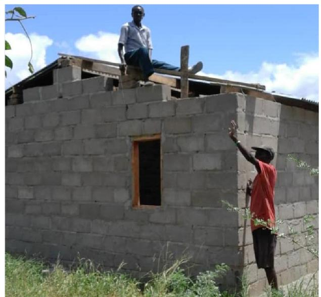
*Die neueren Häuser wurden mit selbstgepressten Zementziegeln hergestellt*
